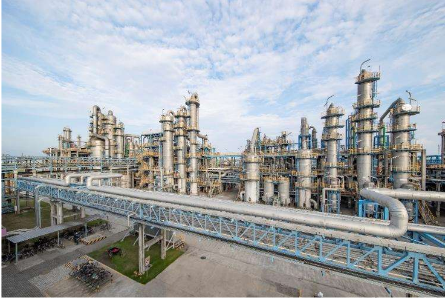
图为：罗姆集团位于上海的甲基丙烯酸酯一体化生产设施
